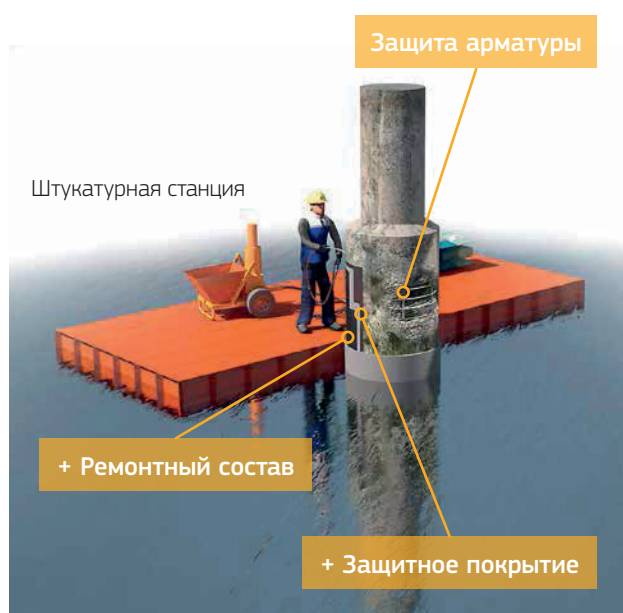
Ремонт надводной части
